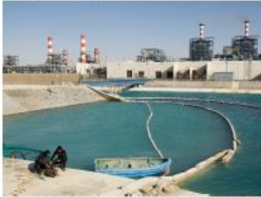
Usine de dessalement de l'eau de mer | Abu Dhabi, Emirats Arabes Unis |
